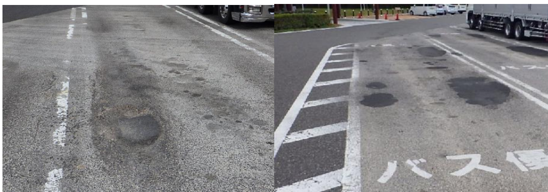
阿武隈PA(上り線)駐車場舗装現況
